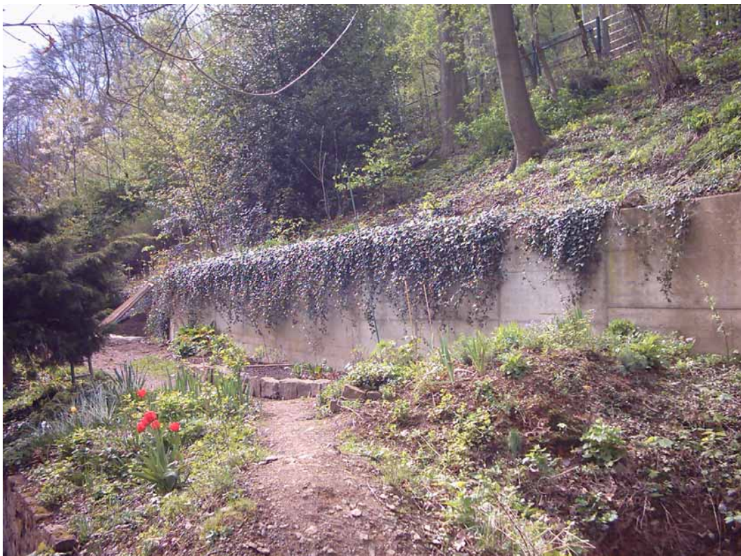
Durchlaufende Betonabstützung des Hanges.
